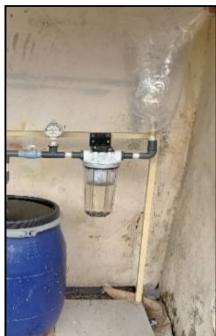
Gambar 6. Penampung biogas pada digester kedua
